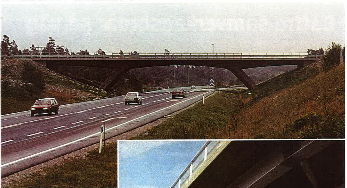
Fig 2. Konventionell snedbening i betong
