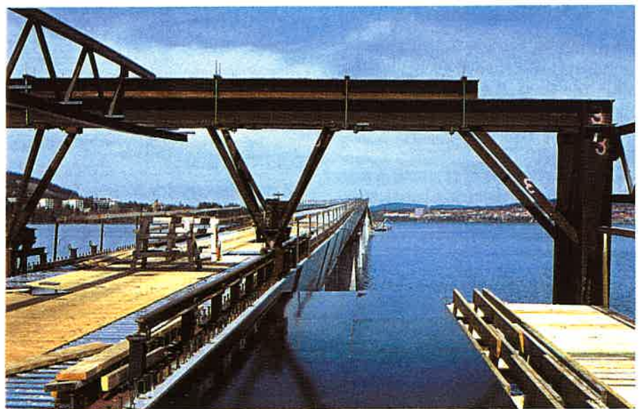
Fig 11. Formbuss använd för bro över Vallasundet.
