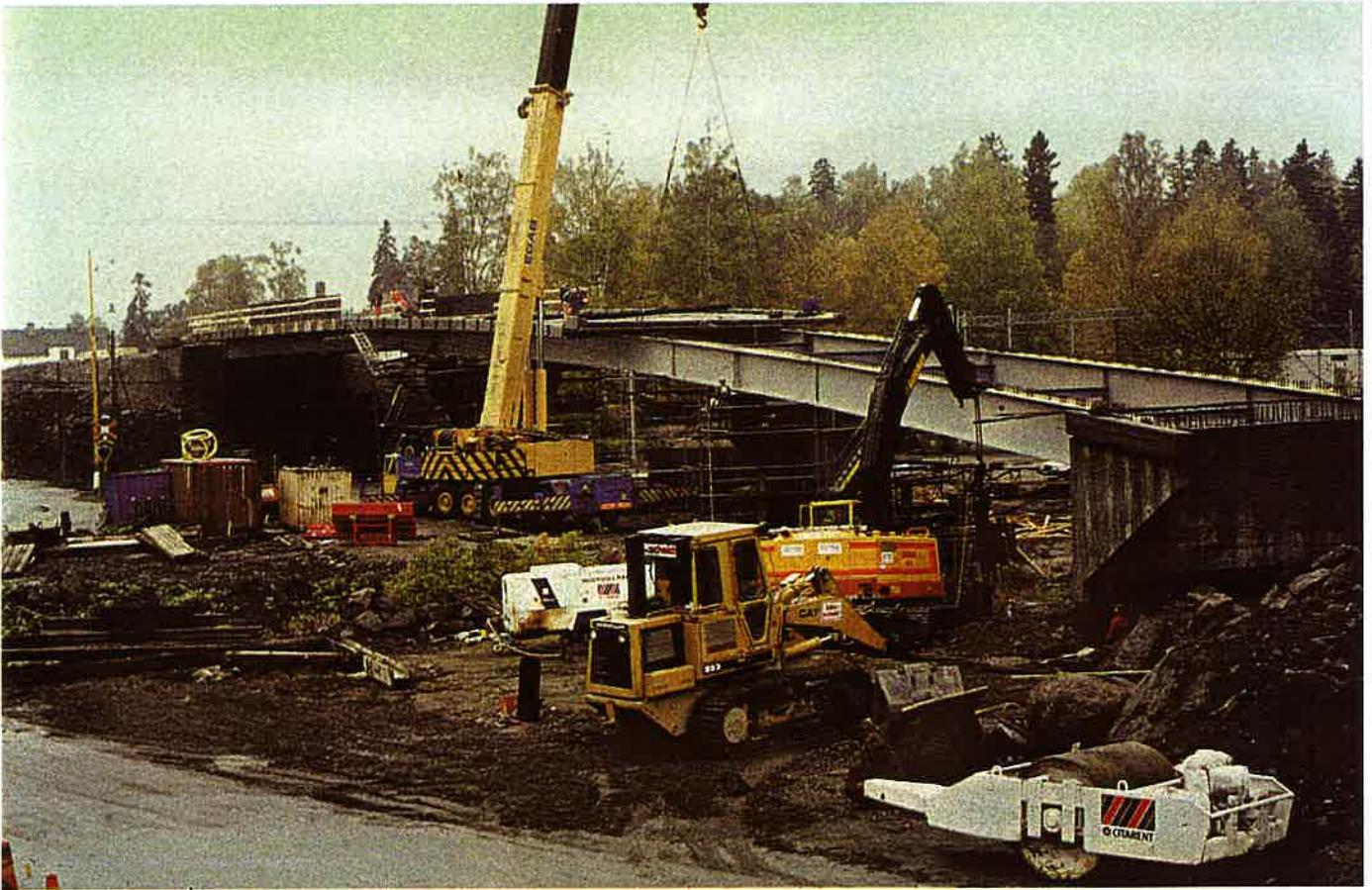
Fig 9. Elementmontage för en vägbro över järnväg.
