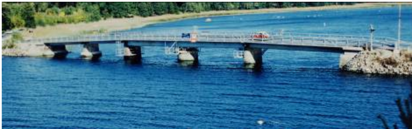
Fig. 1: Tottnäsbron med aluminiumdeck (Foto SAPA)
